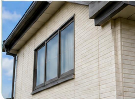
外壁・窓まわりの確認画像
