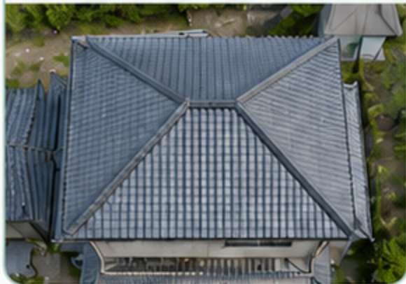
屋根全体の俯瞰画像
